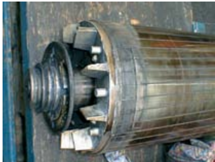
Obr.: poškození rotoru o statorový paket a poškození hřídele při úplném zničení ložisek.
